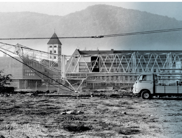
Neubau des Wirtschaftsgebäudes am Johannesgymnasium in Lahnstein
